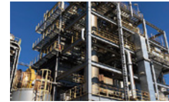
廃棄物焼却施設
