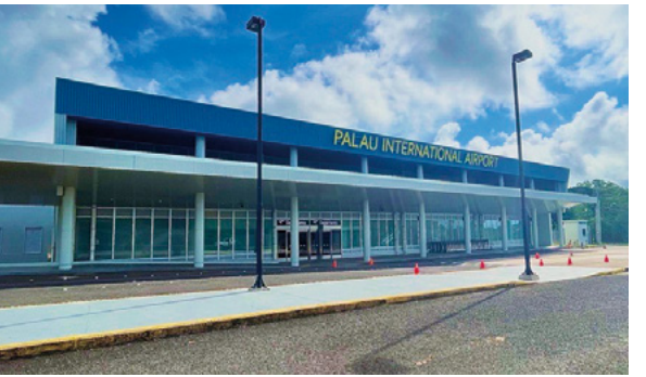
パラオ国際空港旅客ターミナル
