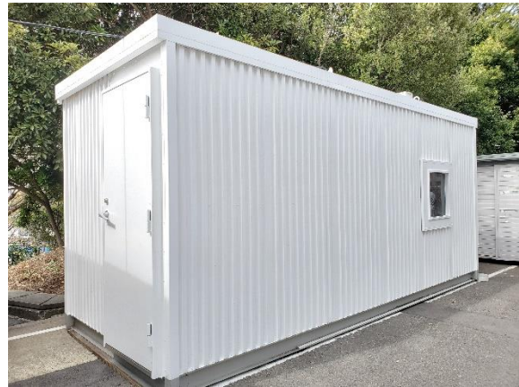
本素材施工済の倉庫
