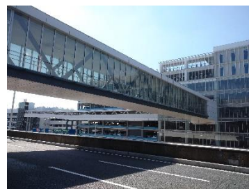
本素材施工済の第4駐車場連絡橋 ※室内温度の 17%低下確認済
