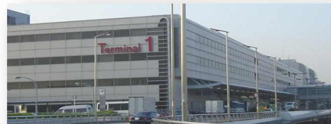
羽田空港第1旅客ターミナルビル
