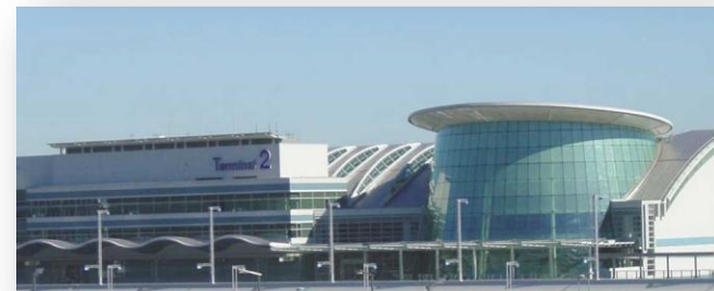
羽田空港第2旅客ターミナルビル
