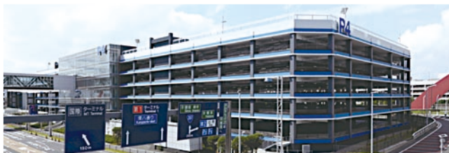
P4立体駐車場外観
