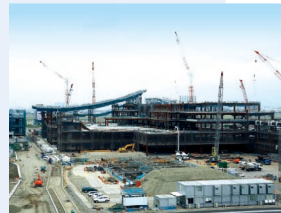
建設中の新国際線旅客ターミナルビル(2009年5月現在)
