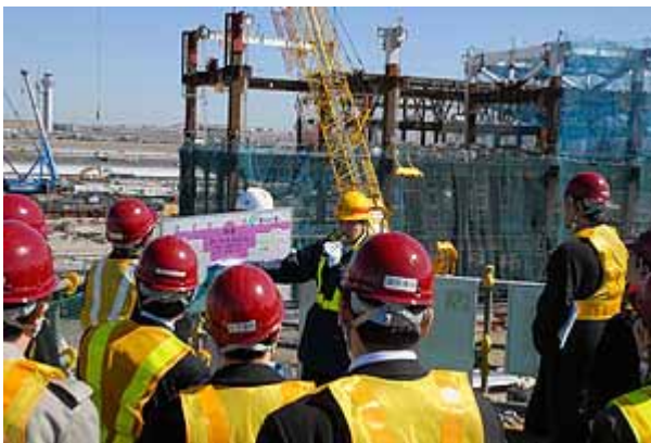
建設工事現場での京浜急行電鉄(株)担当者による説明
