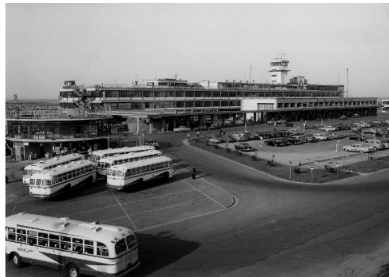
開館当時の羽田空港旅客ターミナルビル
