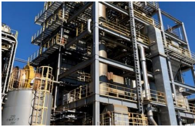
廃棄物焼却施設
