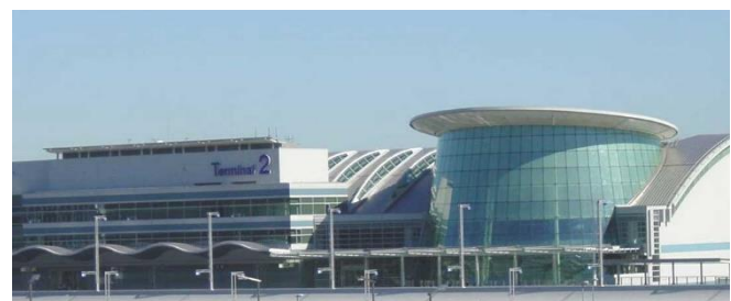
羽田空港第2旅客ターミナルビル
