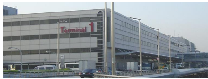
羽田空港第1旅客ターミナルビル
