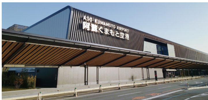
熊本国際空港旅客ターミナル
