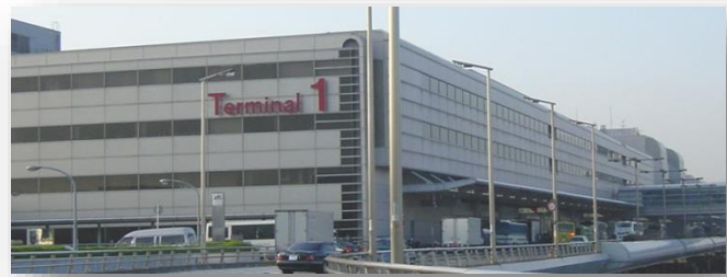
羽田空港第1旅客ターミナルビル
