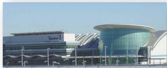
羽田空港第2旅客ターミナルビル
