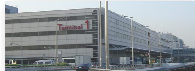
羽田空港第 1 旅客ターミナルビル
