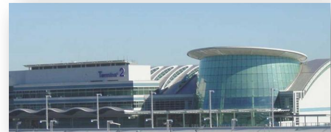
羽田空港第 2 旅客ターミナルビル
