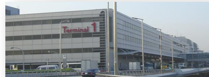
羽田空港第1旅客ターミナルビル
