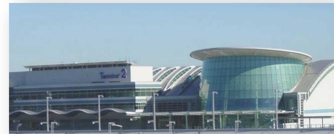
羽田空港第2旅客ターミナルビル
