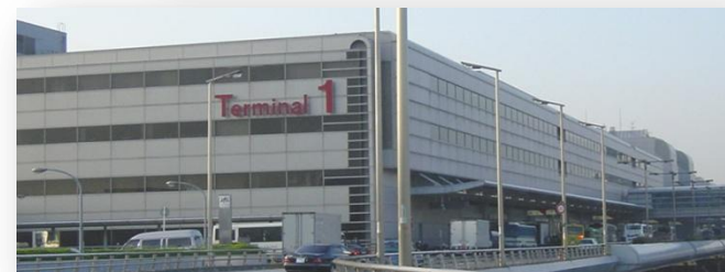
羽田空港第1旅客ターミナルビル
