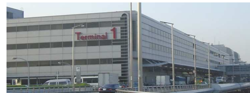
羽田空港第1旅客ターミナルビル
