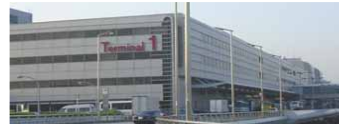
羽田空港第1旅客ターミナルビル
