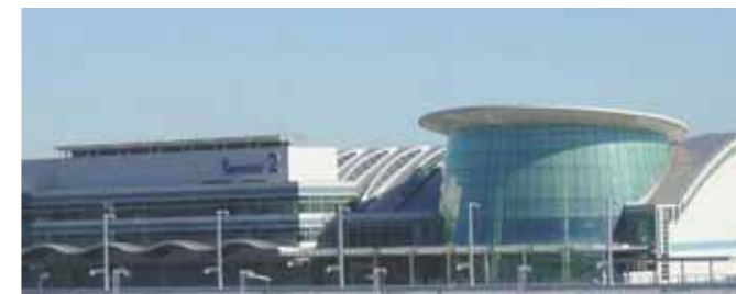
羽田空港第2旅客ターミナルビル
