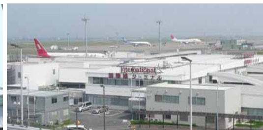
羽田空港国際線旅客ターミナルビル
