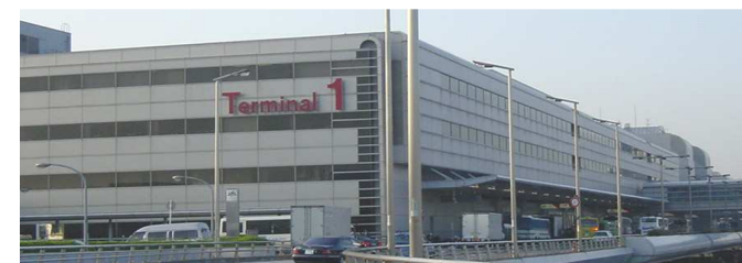
羽田空港第1旅客ターミナルビル
