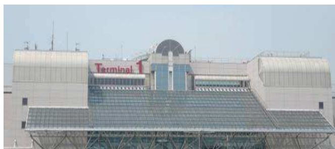
羽田空港第1旅客ターミナルビル
