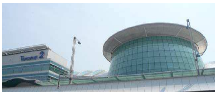
羽田空港第2旅客ターミナルビル
