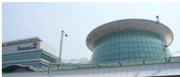
羽田空港第2旅客ターミナルビル
