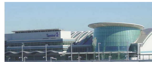
羽田空港第2旅客ターミナルビル
