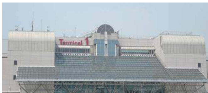
羽田空港第1旅客ターミナルビル
