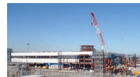
増築工事状況(本年10月現在)
