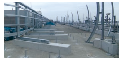
展望デッキ ※ 5月末現在施工状況
