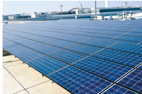
太陽光パネル
