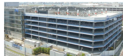
P4立体駐車場工事風景 (2010年5月現在)
