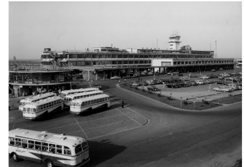
開館当時の羽田空港旅客ターミナルビル
