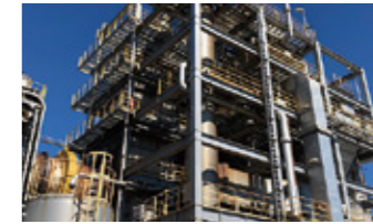
廃棄物焼却施設
