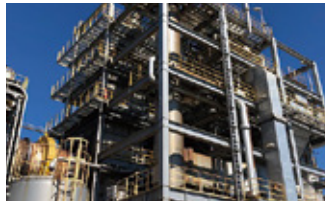
廃棄物焼却施設
